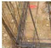
Noeud de chaînage - Continuité mécanique
