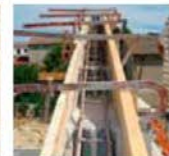
Mise en place d'un chaînage au niveau du rampant d'un bâtiment
