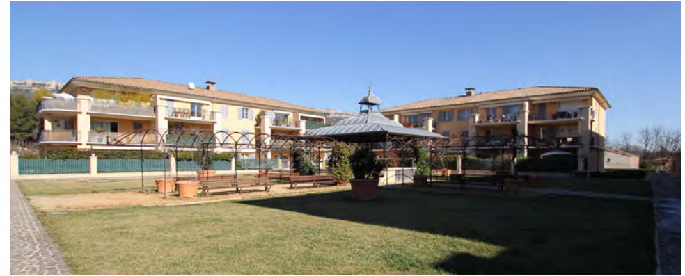
RÉSIDENCE LES TERRASSES DU CHÂTEAU, CHÂTEAUNEUF-LE-ROUGE
