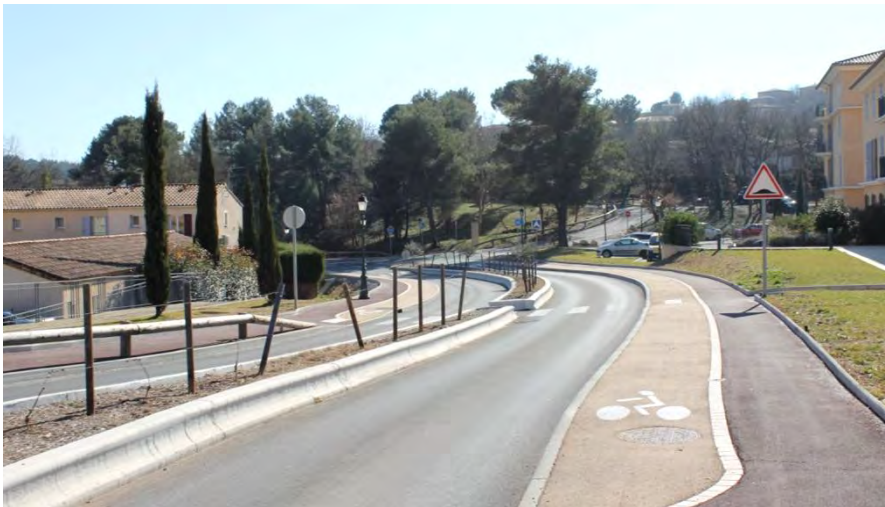
RD46 dédiée et aménagée, desservant le centre-village
