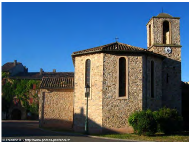
Eglise de Châteauneuf-le-rouge (Source : photo-provence.fr)
